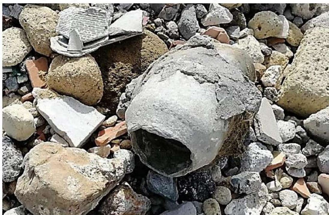
Figura 5 – il colletto di condotta pluviale con bordi di rottura netti in P1 (rif. pag. 7 di 29 relazione tecnica GF )
